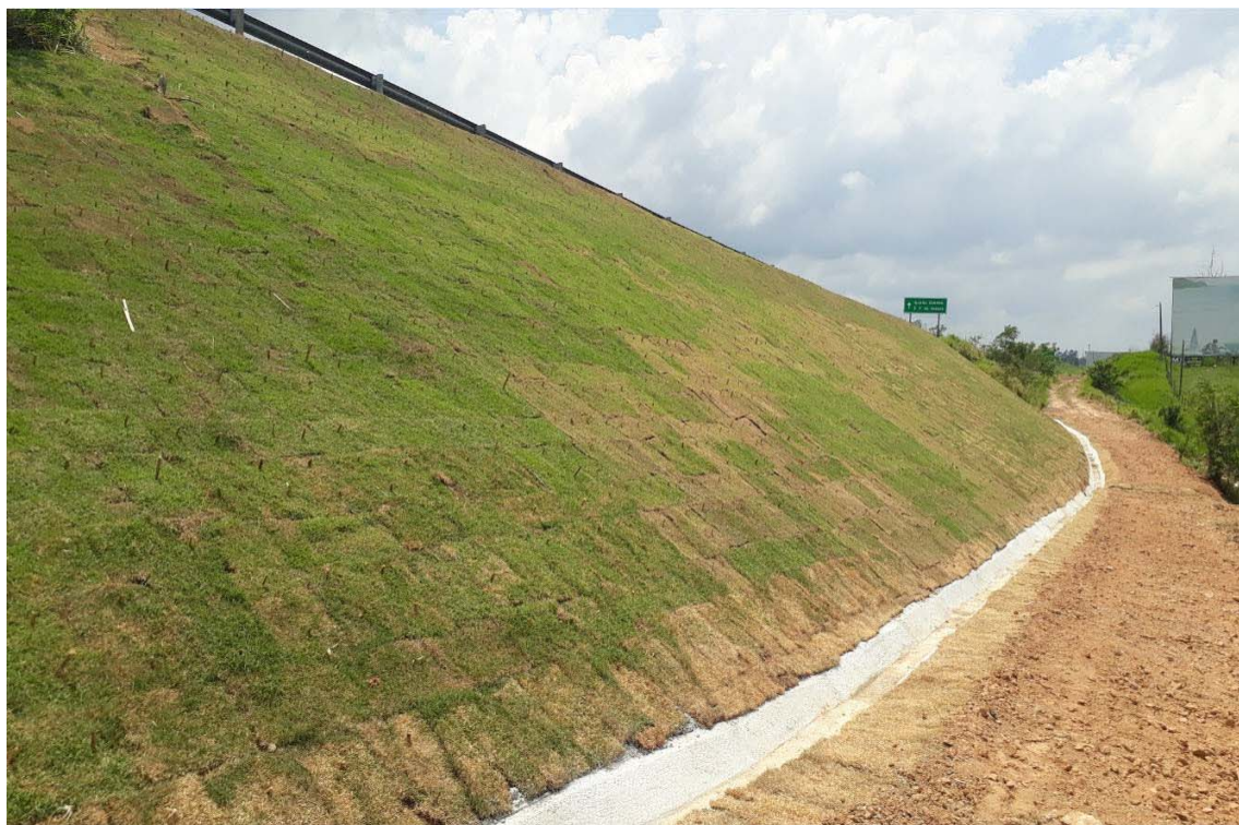
FOTO 25 - Obra de Recuperação de Talude - Km 30+080 Norte F3
