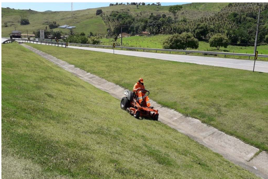
FOTO 14 - Roçada Mecânica - Km 17+400 Sul F1
