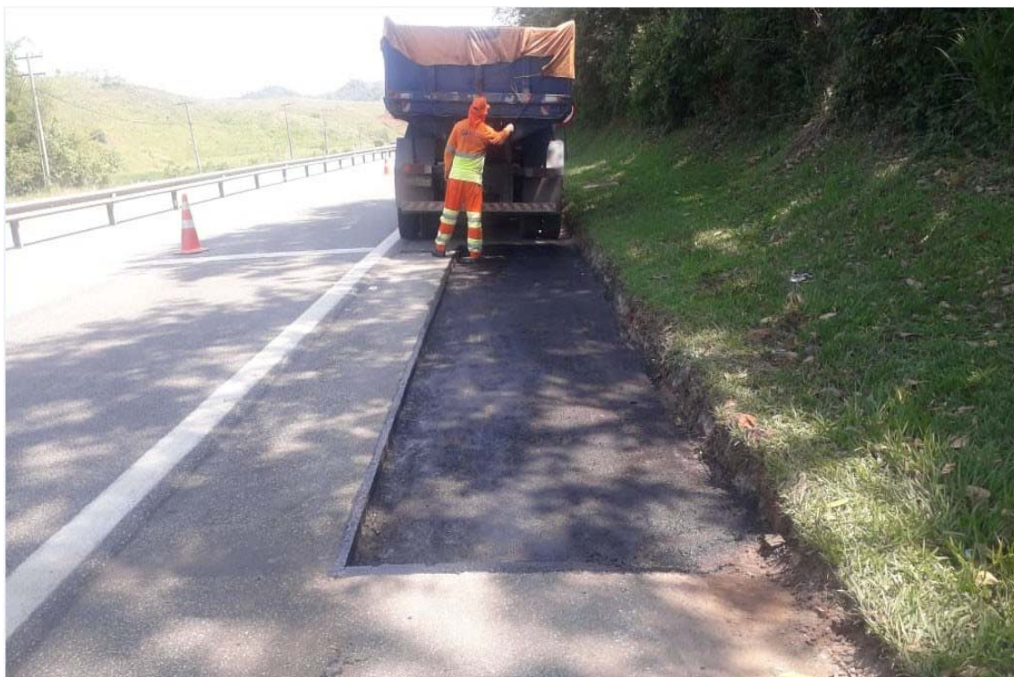
FOTO 01 - Acostamento - Reparo Profundo - KM 7+500 Sul F1
