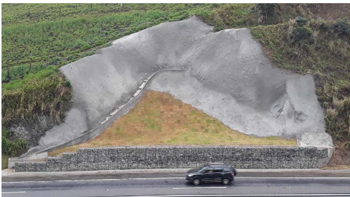
FOTO 22 - Obra de Recuperação de Talude - Km 9+760 Norte F4
