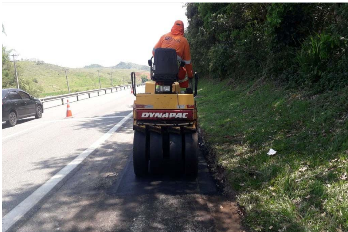
FOTO 02 - Acostamento - Reparo Profundo - KM 7+500 Sul F2
