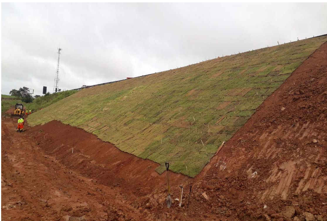
FOTO 24 - Obra de Recuperação de Talude - Km 30+080 Norte F2
