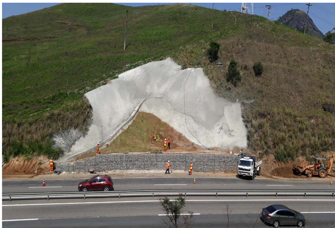
FOTO 20 - Obra de Recuperação de Talude - Km 9+760 Norte F2
