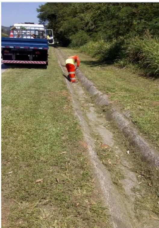
FOTO 12 - Limpeza Valeta de Corte - Km 19+000 Sul F2
