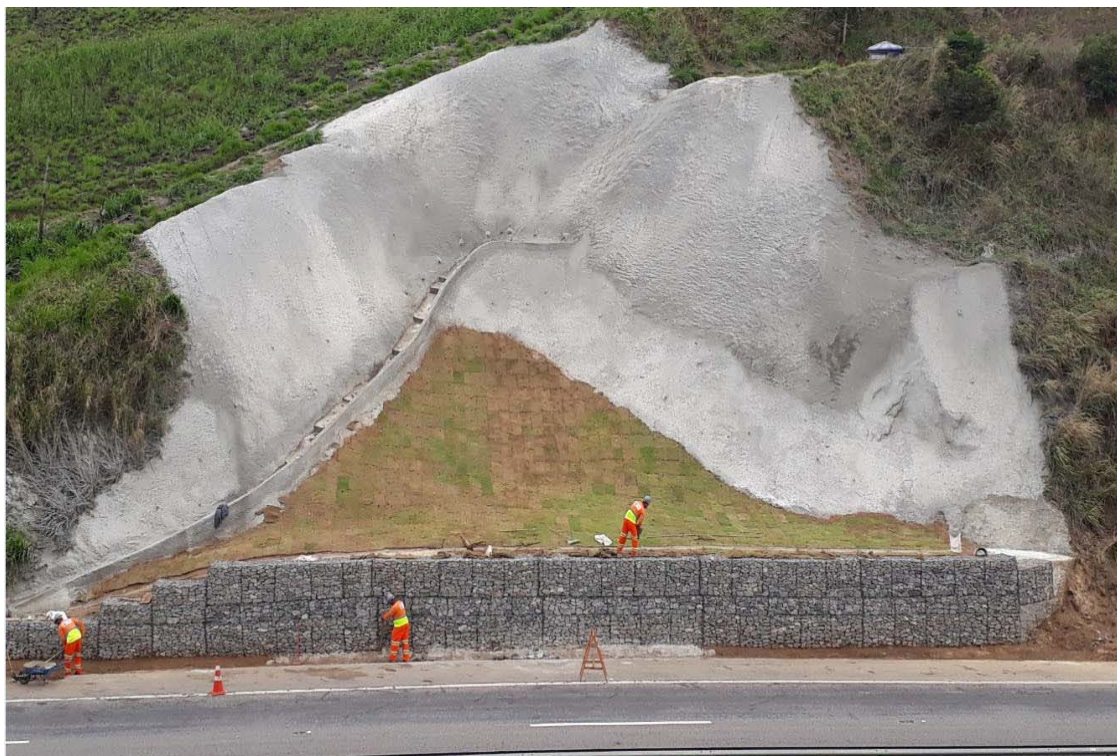
FOTO 21 - Obra de Recuperação de Talude - Km 9+760 Norte F3
