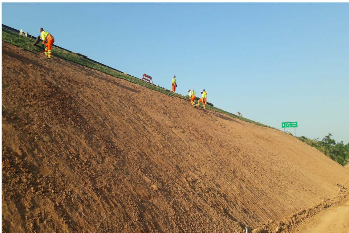
FOTO 23 - Obra de Recuperação de Talude - Km 30+080 Norte F1
