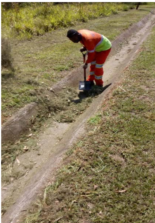
FOTO 11 - Limpeza Valeta de Corte - Km 19+000 Sul F1
