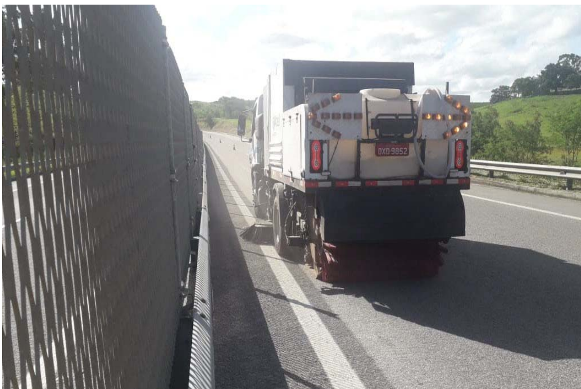
FOTO 16 - Varrição de Mediana - Km 45+000 Sul F1
