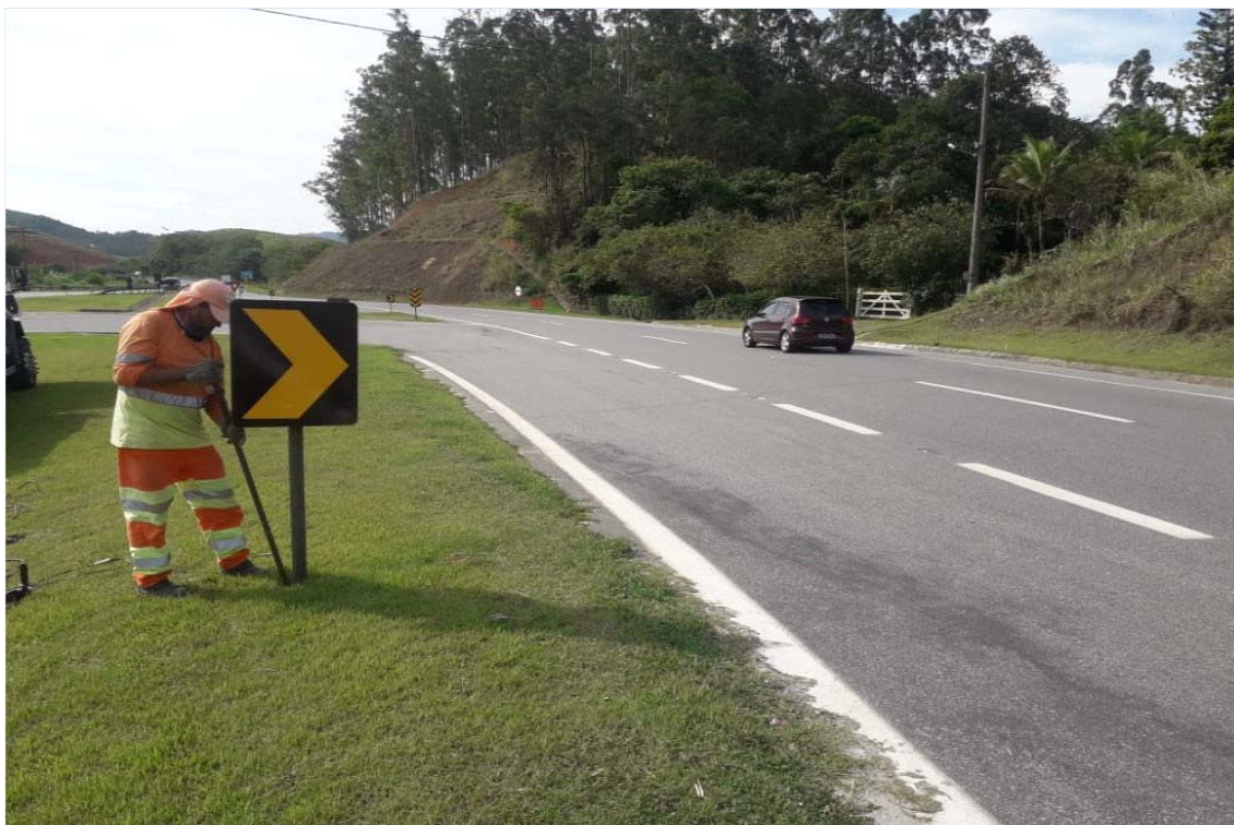
FOTO 07 - Nivelamento de Placa - Km 7+300 Norte F2
