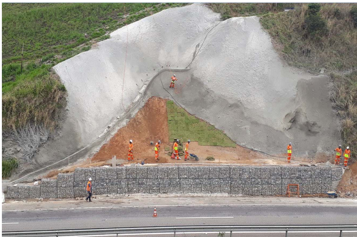
FOTO 19 - Obra de Recuperação de Talude - Km 9+760 Norte F1
